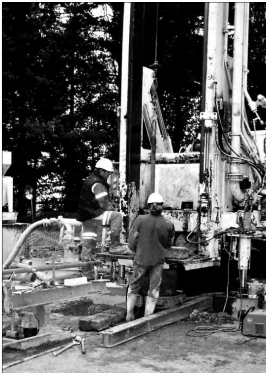
En plein forage
