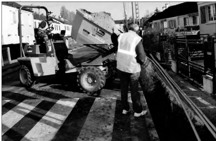
Enfouissement des réseaux rue du Bel-Air
