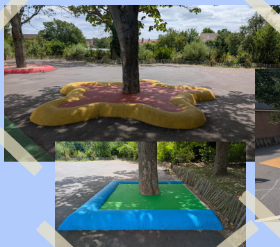
Correction de malfaçons sur les pieds d'arbres de l'école maternelle
